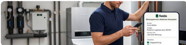
Anlage nach Wartung
